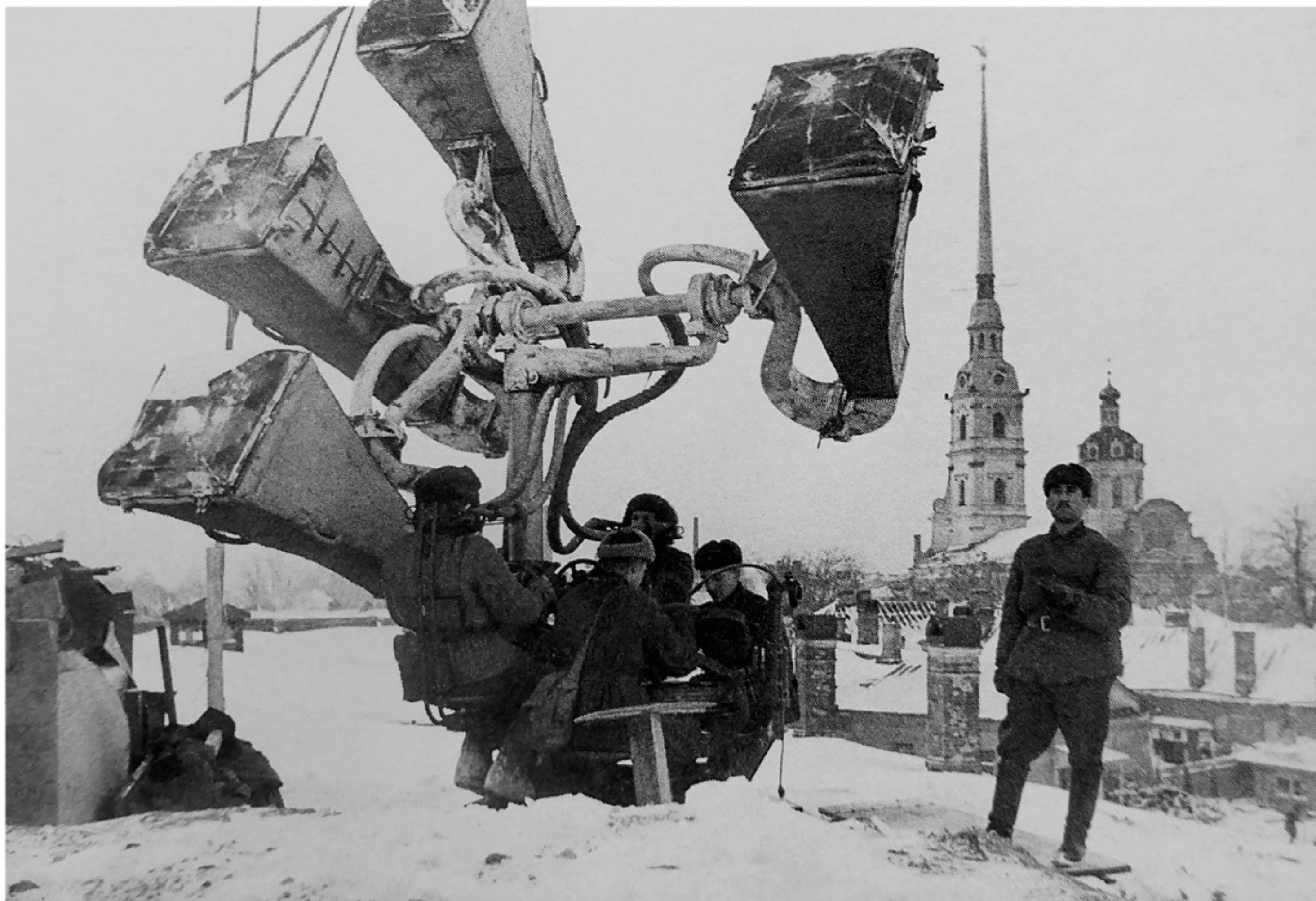
Расчет звукоулавливателя ЗТ-5 на крыше бастиона Петропавловской крепости в Ленинграде
