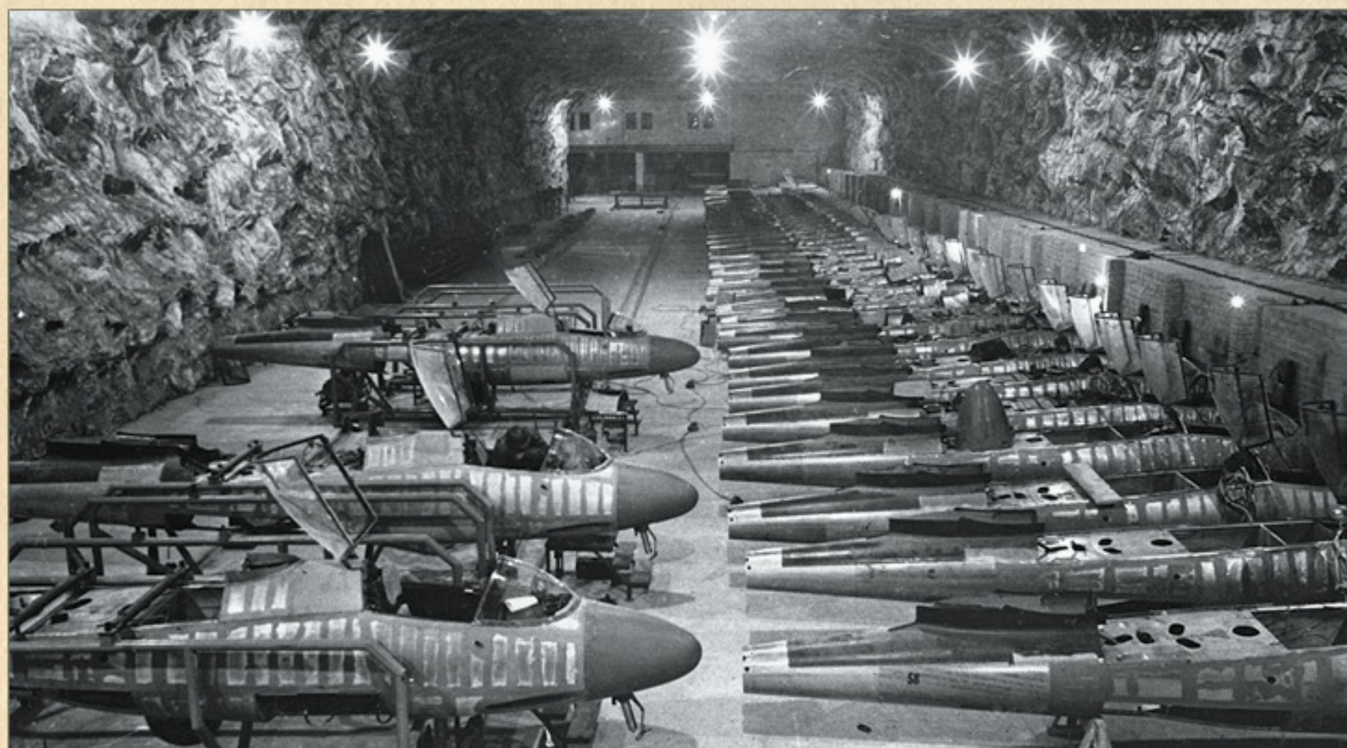
Линия сборки истребителей Хейнкель He-162 на подземном заводе в Тартуне, Германия
